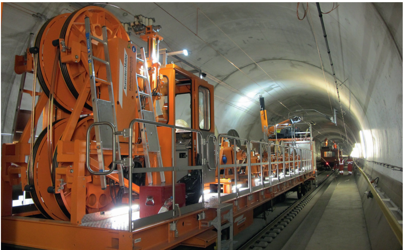
Elektrifizierung des St. Gotthard-Tunnels
