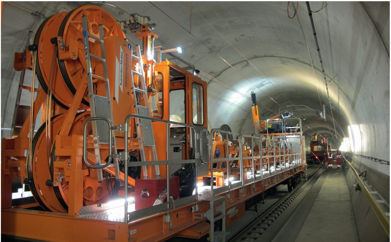
Elektrifizierung des St. Gotthard-Tunnels
