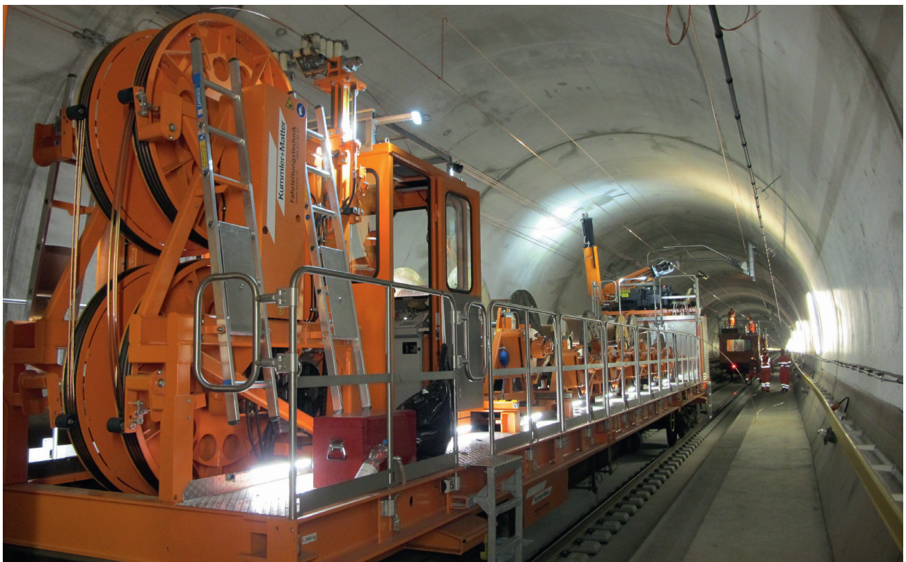
Elektrifizierung des St. Gotthard-Tunnels
